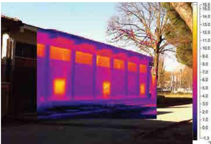
Da questa immagine si nota chiaramente la posizione degli elementi caloriferi in funzione all'interno della palestra. Dall'entità delle differenze di temperatura le dispersioni termiche di questo edificio sono molto elevate.
